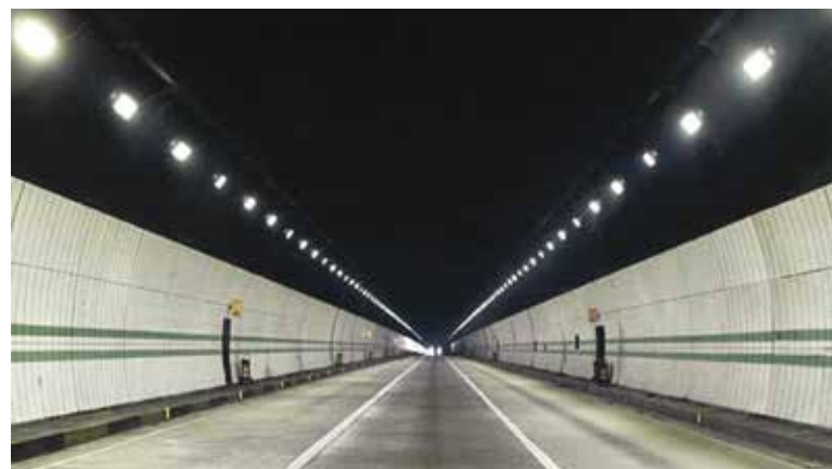
3. Un esempio di illuminazione ad induzione in un tunnel
